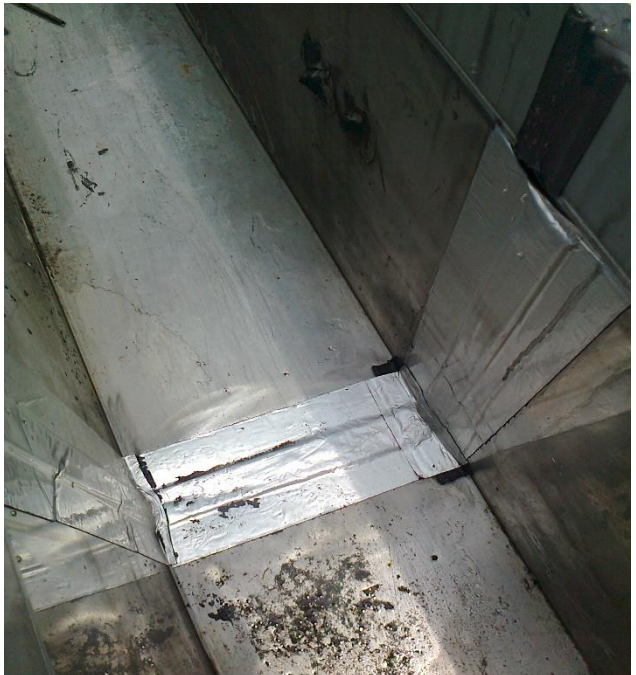
(圖四) 再貼附 丁基橡膠 No.412 鋁箔防水膠帶
