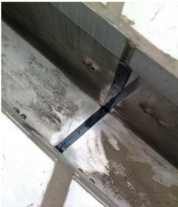
(圖三) 貼合 丁基橡膠 No.5032-30mm 防水膠帶
