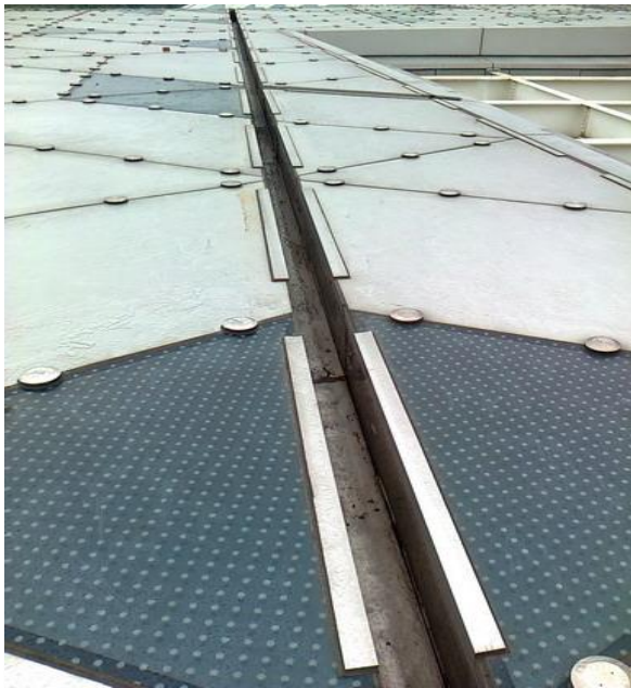
(圖三) 貼合 丁基橡膠 No.5032-30mm 防水膠帶
