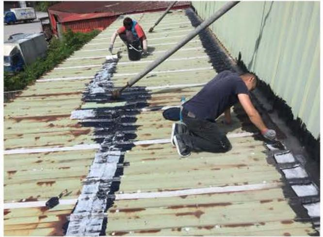
生鏽漏水處先做清潔，剪裁合適大小的【4075 單面不織布丁基橡膠防水膠帶】，黏貼覆蓋需修補處，再噴塗所需漆種即可！
