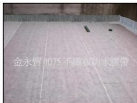
⑫. 以相同步驟鋪貼其它卷防水毯，搭接處需以 No. 5031 寬 10cm 打底，再疊合貼上 No. 4075。
