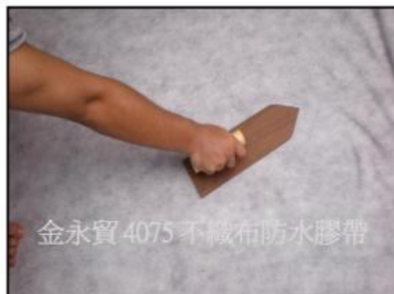
⑧. 4075 攤開，黏著面朝下，不織布基材朝上。以木製鏟刀將膠布抹平，使之平貼於平面。
