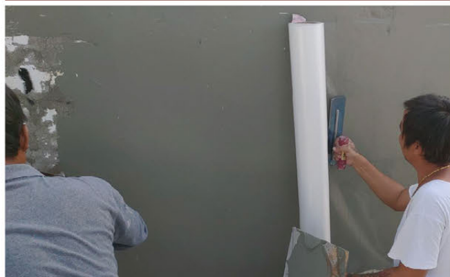
816PE 抗裂加強網 (非自黏) 拉皮實際案場
