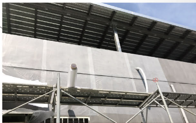
816PE 抗裂加強網 (非自黏) 拉皮實際案場
